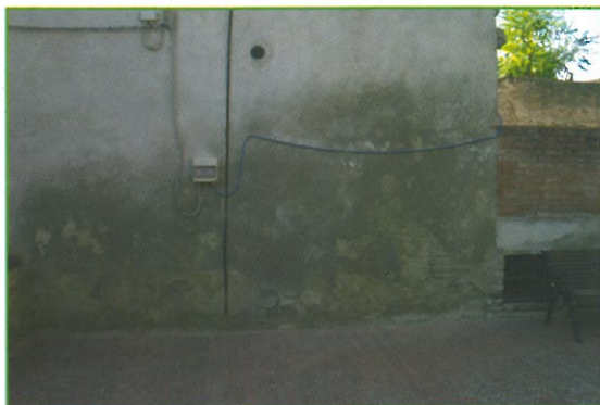
Αλλαγή του χρώματος, ελάτπωση της θερμομονωτικής αξίας
